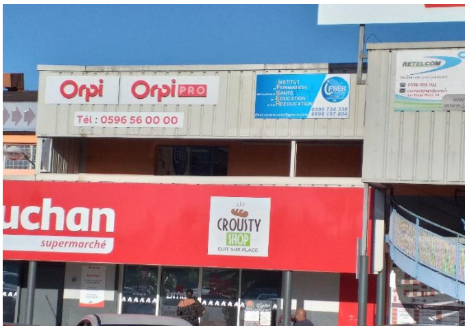
← FACADE AVANT de l'immeuble
